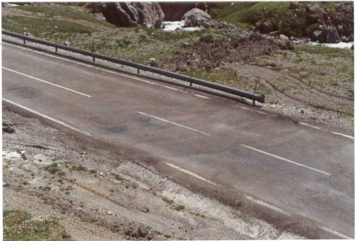
Fotografía n.º 7.: Vista de la zona de represamiento y sumidero de es co rrerías y de los parches precisos en la calzada para permitir el tráfi co . (SituaciónA).
