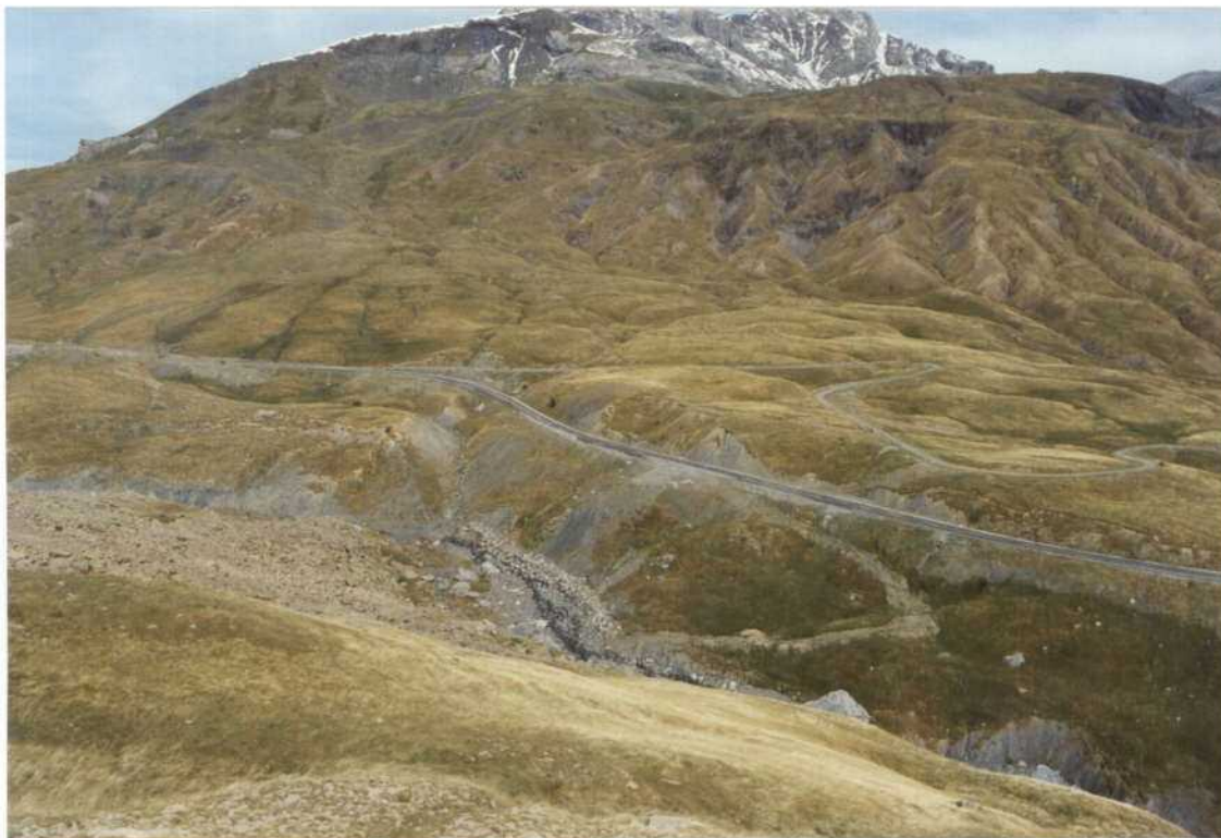
Fotografía n.º 1.: Panorámica general del tramo de la Carretera C-136 afectado. Obsérvese su situación respecto al río y plano superior.
